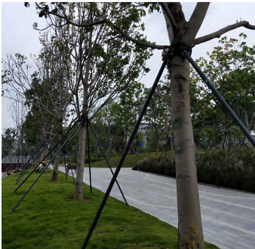
同一路段，支撑材料、支撑形式、支撑角度、绑缚形式等宜统一
