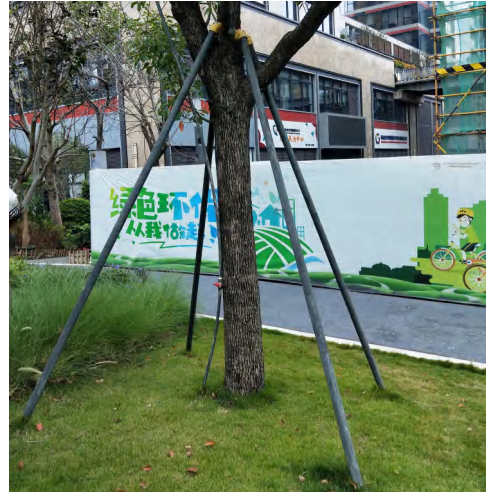
宜选用镀锌管支撑材料的支撑柱，支撑柱与树木连接处衬软垫
